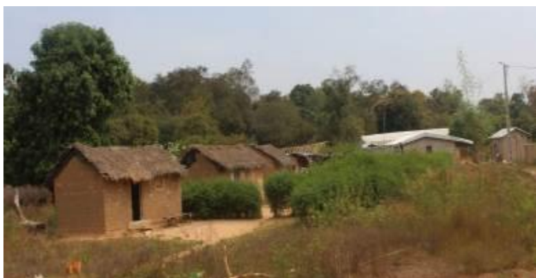
Figure 2: maisons en banco avec toiture en paille dans le village de Panagana
