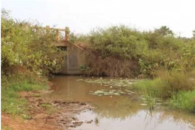
Figure 9: Pont à l'entrée du village de Panagana
