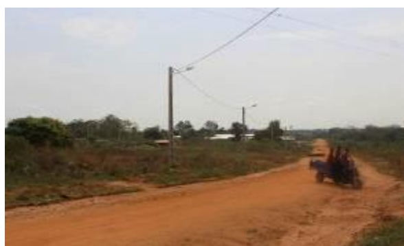
Figure 2: Voie non bitumée accédant au village de Panagana
