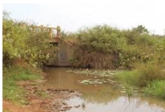
Figure 3: Pont à l'entrée du village de Panagana
