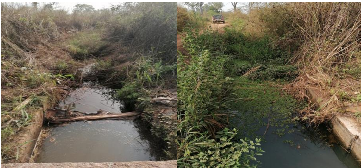
Planche 3-3 : Vues du canal primaire rive gauche – Hambol 13
