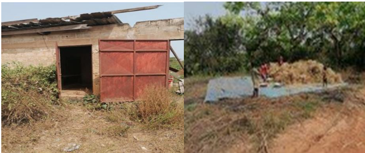
Planche 3-10 : Vues du magasin de stockage et d'un espace de battage non aménagé
