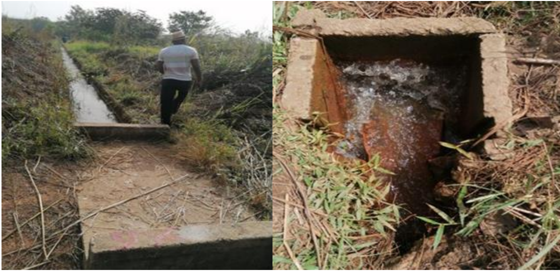
Planche 3-5 : Vues d'un dalot et d'un ouvrage de chute sur un canal secondaire - Hambol 13
