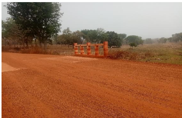
Photo 3 : Voie d'accès au site du barrage de Kiémou
